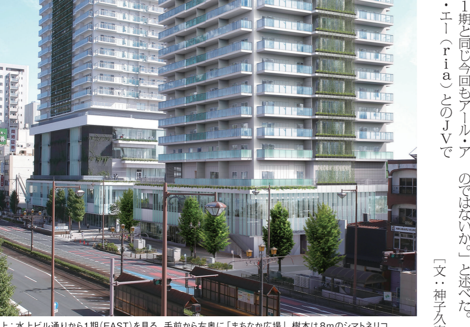
上：水上ビル通りから1期(EAST)を見る。手前から左奥に「まちなか広場」、樹木は8mのシマトネリコ 下：手前から今回の2期(WEST)、あだに「まちなか広場」、その向こうが1期(EAST)
