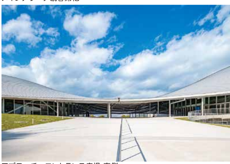
アプローチイベントラント広場 南側
