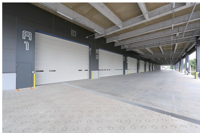
ピロティ型車路
