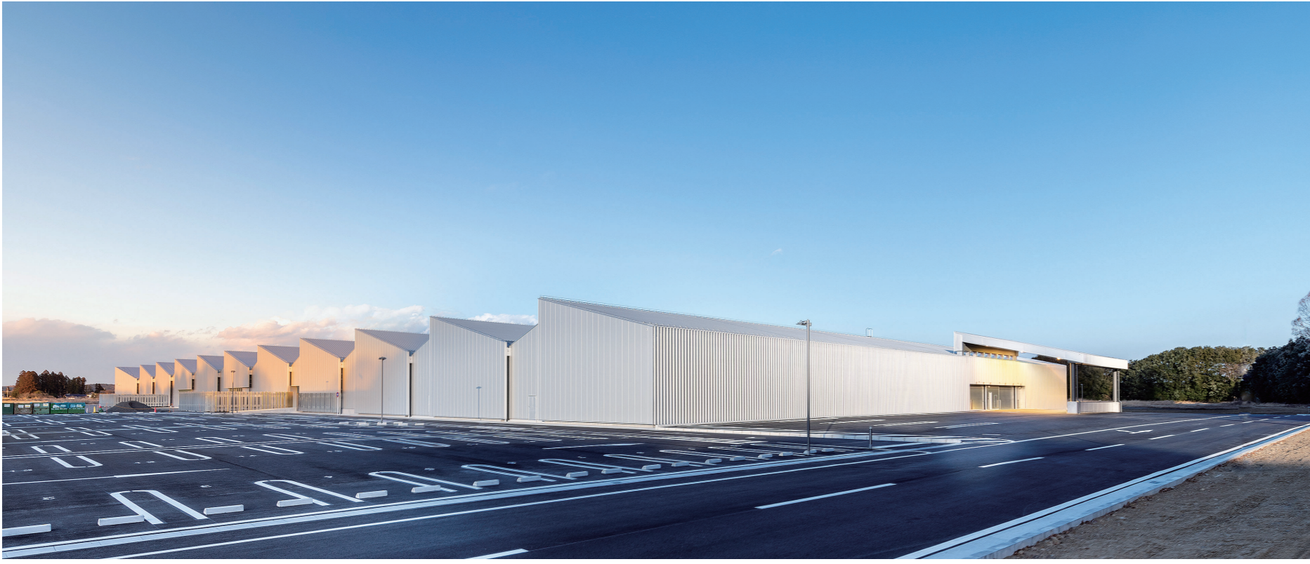
写真提供 | 清水建設株式会社
