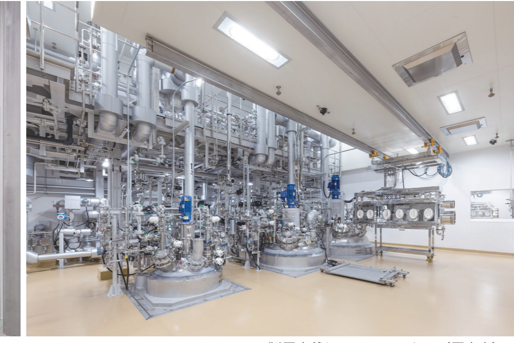
ハステロイ製反応釜とアインレーター(反応室)
