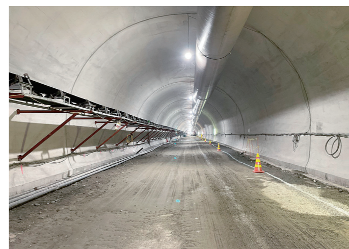
ベルトコンベヤー設置状況(覆工完了部)
