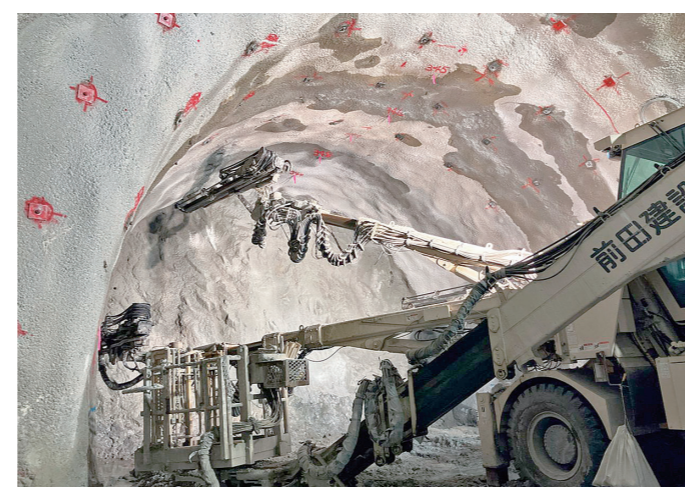
フルオートドリルジャンボ自動削孔状況
