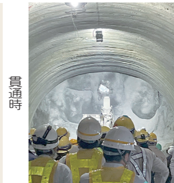
フルオートドリルジャンボ自動削孔状況
