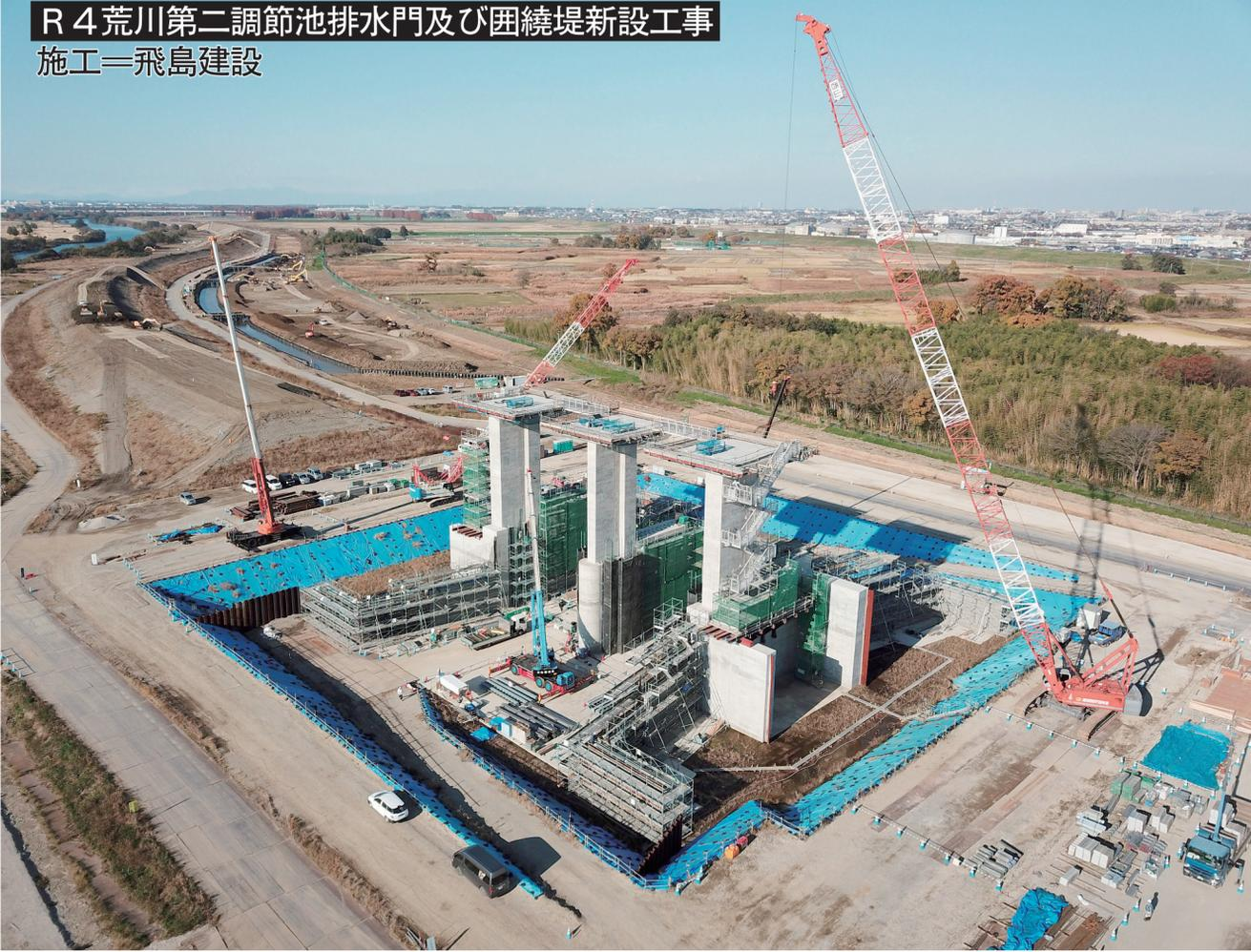
埼玉県と東京都を流れる荒川で、治水安全度向上を目的に調節池の整備が進む。さいたま市桜区の現場では、飛鳥建設が最先端の建設DXを取り入れ、第二調節池の囲繞(いぎょう)堤や排水門などを建設する工事を手掛けている。
