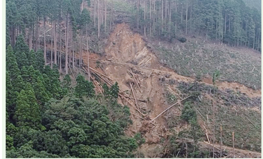
能登半島地震で被災した橋梁の点群データ画像(九州地方整備局提供)
