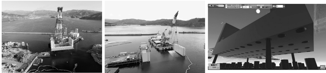
函体およびゲート本体据付状況
