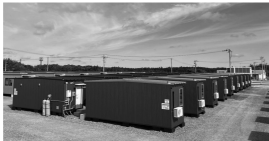
設置完了後の様子
