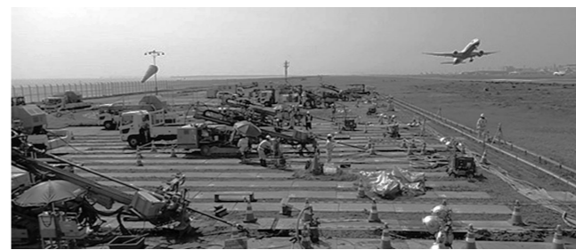
滑走路横からの曲がり削孔
