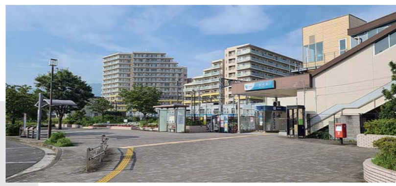
マンションが立ち並び小田急線開成駅周辺では人口増加が続く
