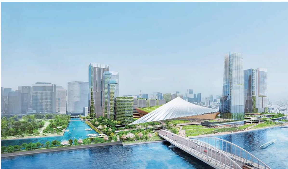
築地地区まちづくり事業の完成イメージ (三井不らの公表資料から)
