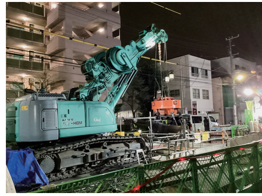
立坑施工状況
