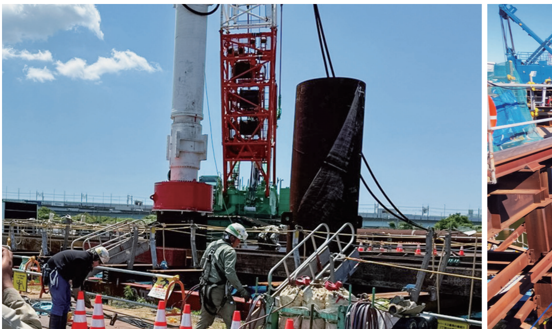
油圧ハンマーによる鋼管杭打設
