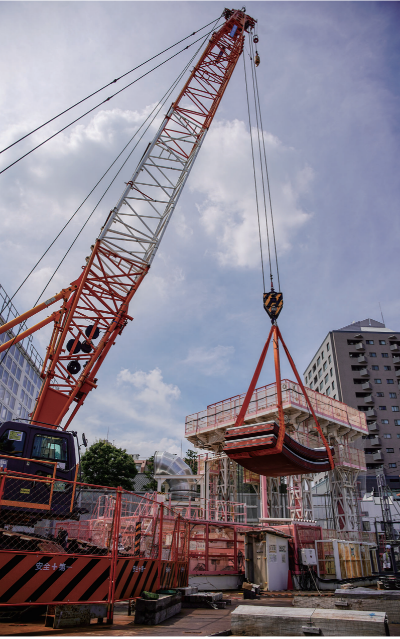
鋼材・コンクリート一体の強固な合成セグメント。1リング9分割している
