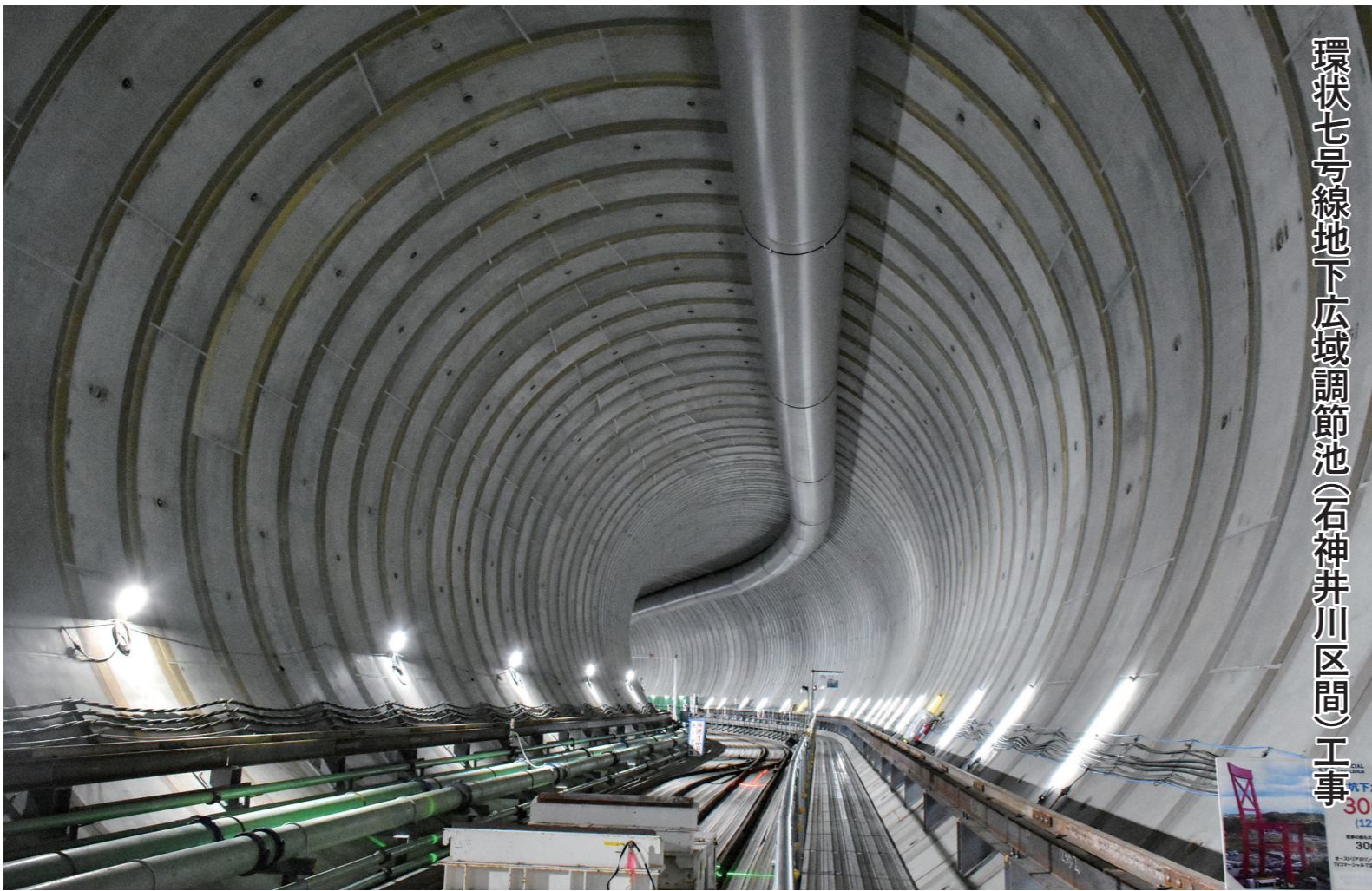
急曲線部3カ所の施工ルートを掘り進める
