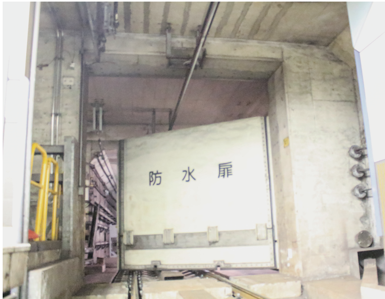
蔵前駅内回り線の防水扉を駅側から見る
