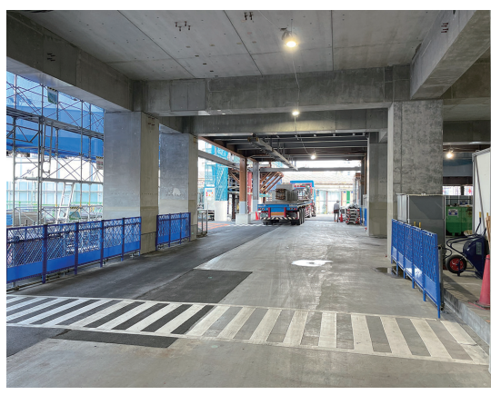
搬入路(前田建設提供)
