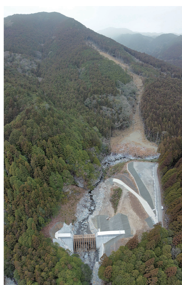
土石流リスクと隣り合わせて作業を進めた
