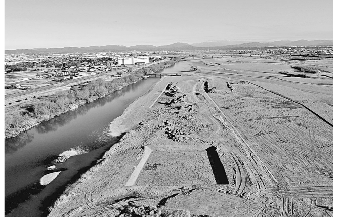
下流側から望む現場
