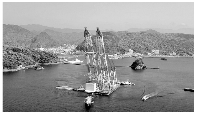
HBケーソン吊曳機状況
