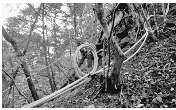
安全対策のためのトラロープ設置
