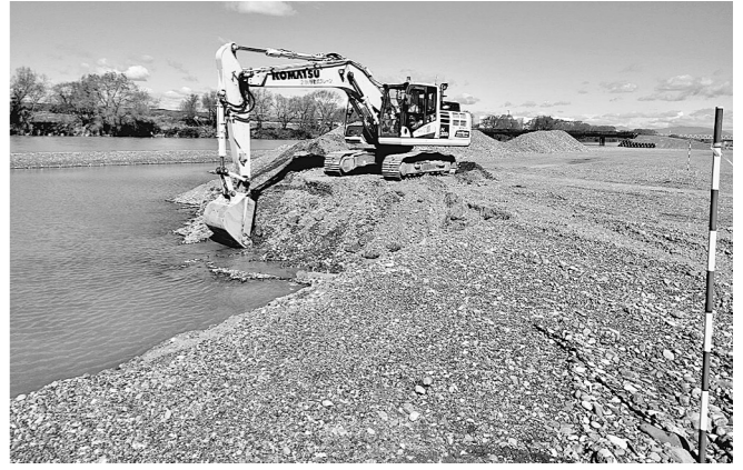
バックホウによる河道掘削の様子
