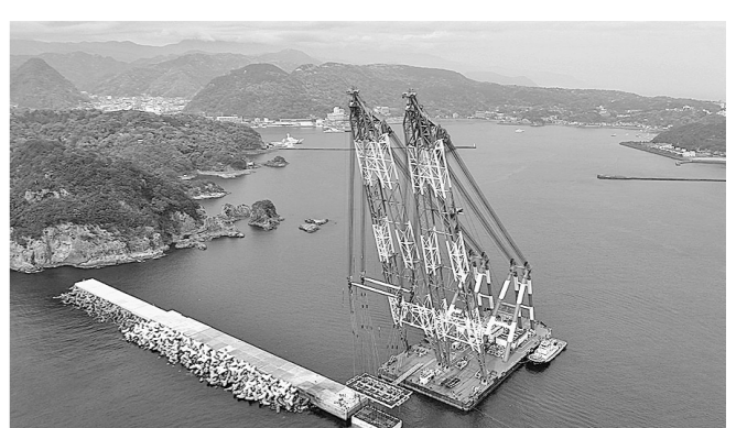
HBケーソン据付状況
