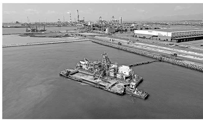
揚土船による揚土状況
