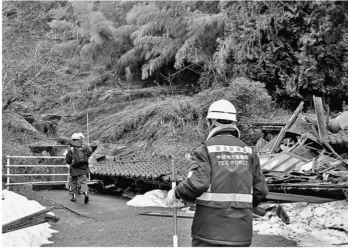
砂防班の被災状況調査(輪島市門前町)
