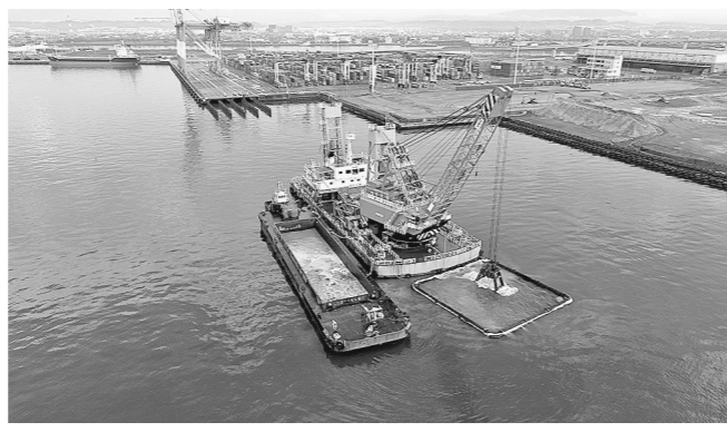
浚渫船による床掘状況
