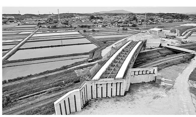
架設後の状況
