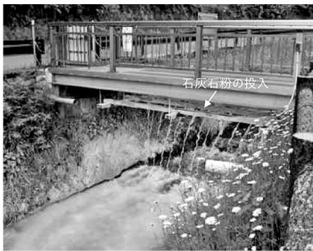
ダム流入河川における石灰石投入による中和処理の状況
