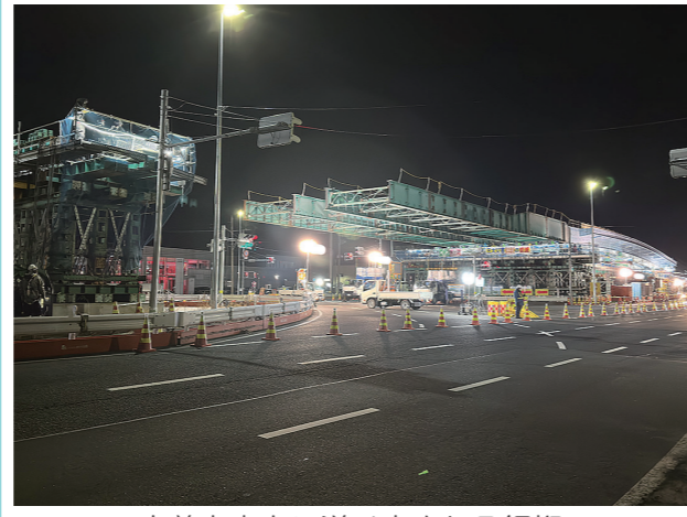
交差点真上に送り出される鋼桁 (2023年2月3日撮影)
