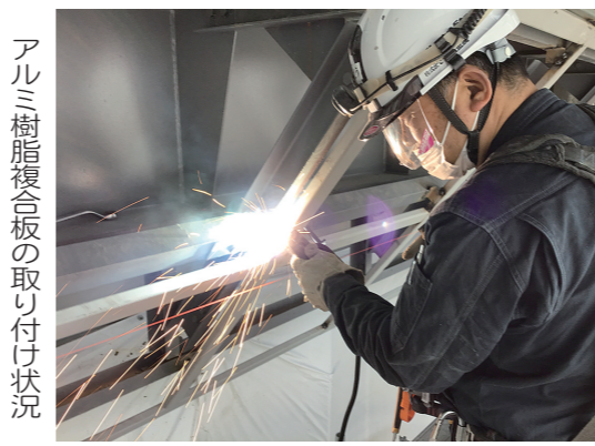
アルミ樹脂複合板の取り付け状況
