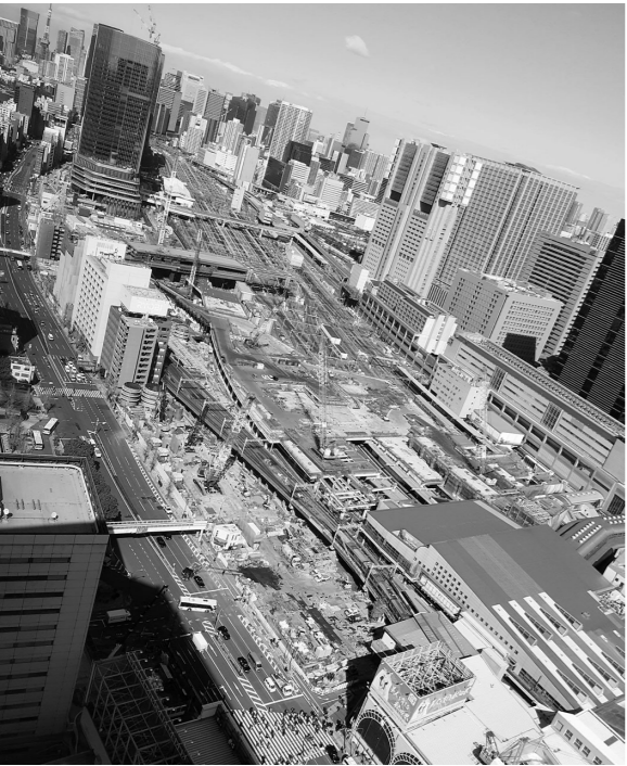
複線プロジェクトが進む品川駅高輪口
