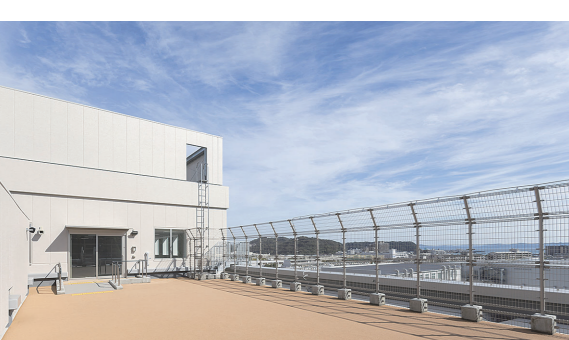
6階 屋上リハビリスペース
