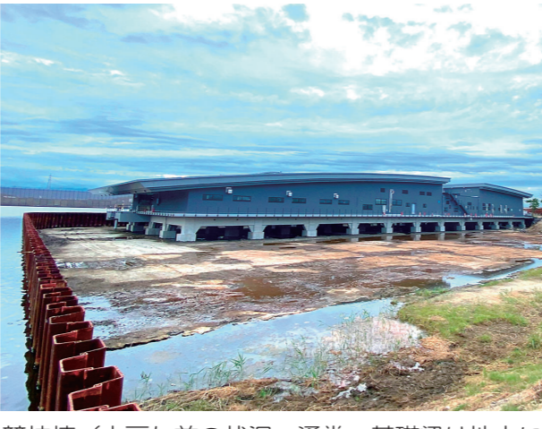
競技棟(水戻し前の状況。通常、基礎梁は地中に埋まっているが、空中に浮く形になっている)
