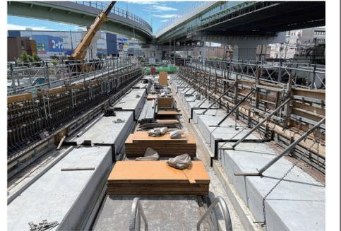
淀川左岸線(2期)関連で実施中の海老江JCT(仮称)工事(擁壁の施工) (阪神高速道路㈱提供)
