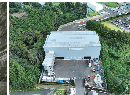
玉里発進立坑
