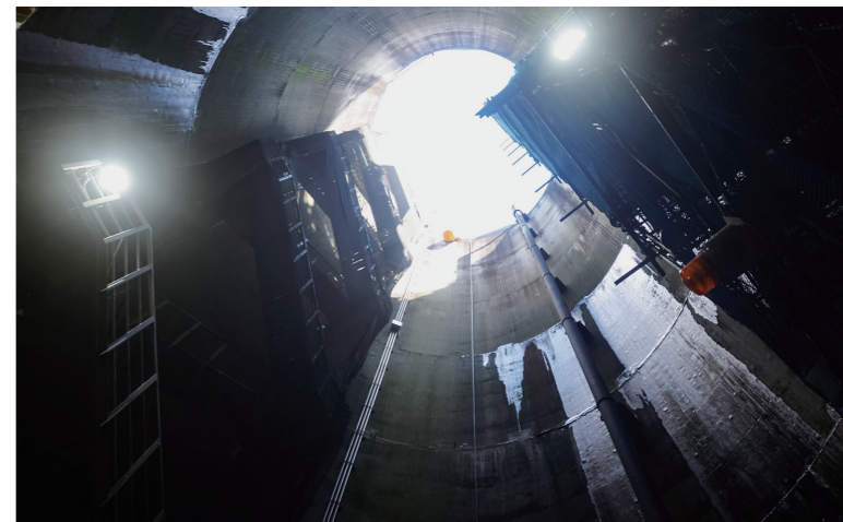
地下約40mの水戸立坑
