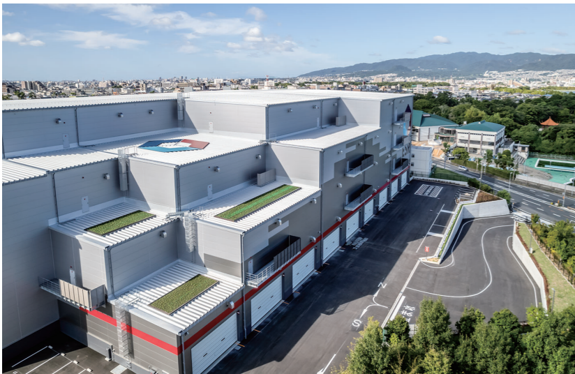
屋上緑化・サイン
