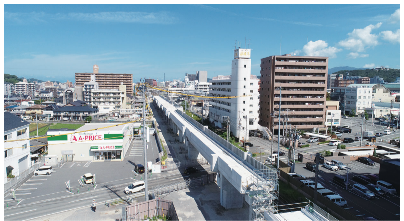
工事終点より松山駅を望む
