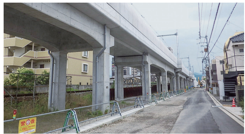
高架橋完成後
