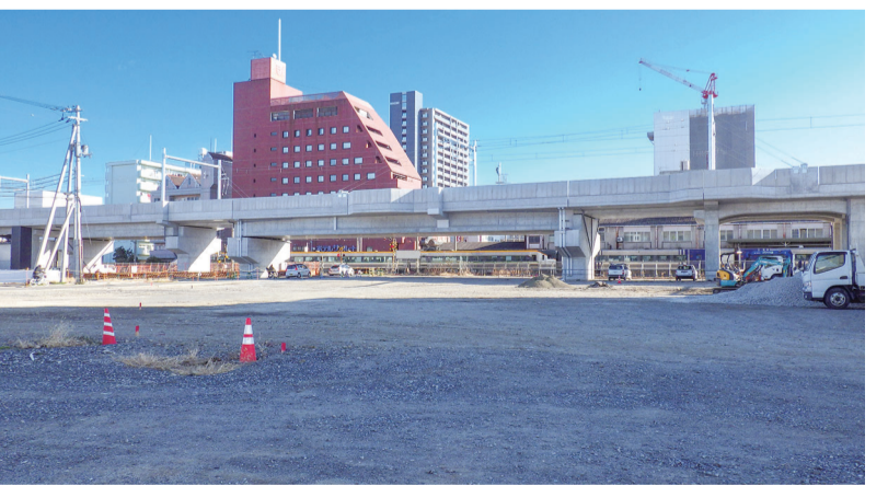
工事起点より松山駅北東方を望む
