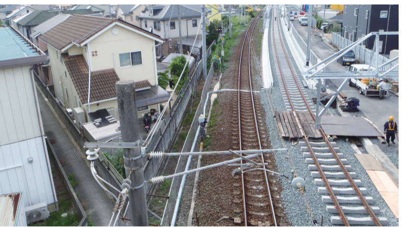
工事起点より松山駅方面を望む
