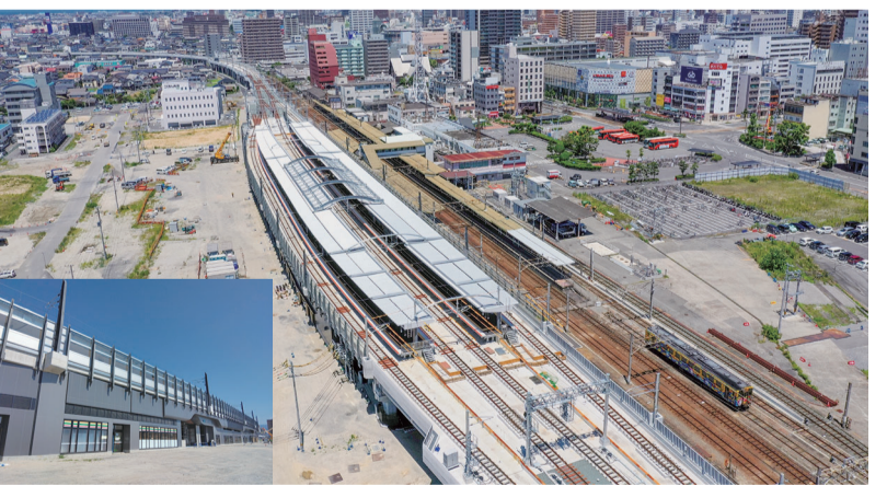
新松山駅を工事終点から望む(左下は新駅舎西面)
