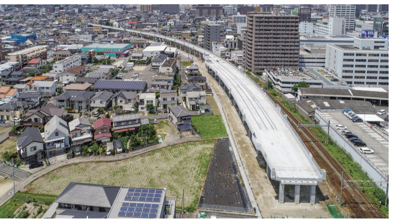
工事終点より高松方面を望む
