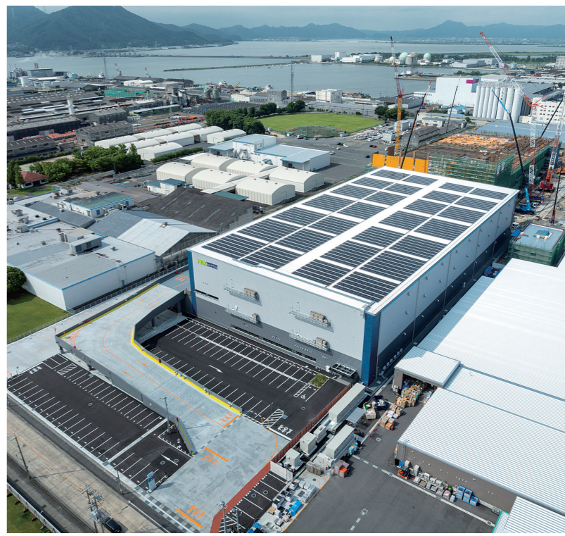
屋上に太陽光パネルを設置
